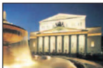
Die Fassade des Bolschoi-Theaters ist derzeit vollkommen von Plänen verdeckt
